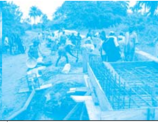
Villageois en train de construire le pont de Iko Town.
