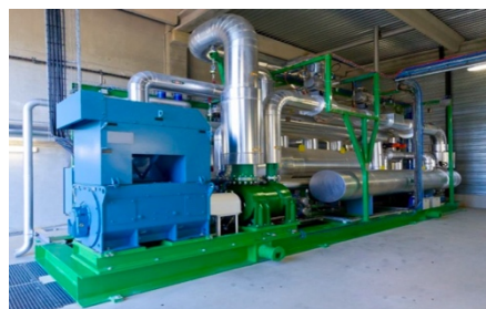
Exemple d'ORC produit par Enertime
